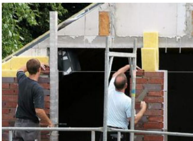
Muratori al lavoro in un cantiere di edilizia residenziale
